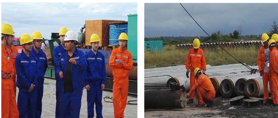
图 11 三航现场施工人员与赴文莱学生在施工现场
