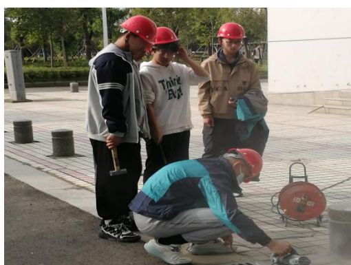
施工专业学生修缮校园设施
